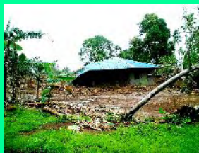
台風災害・被害調査
